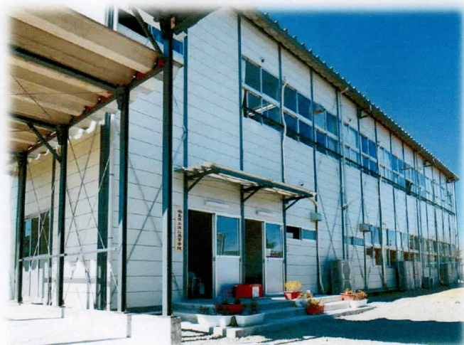
本宮高等学校敷地内 仮設校舎
